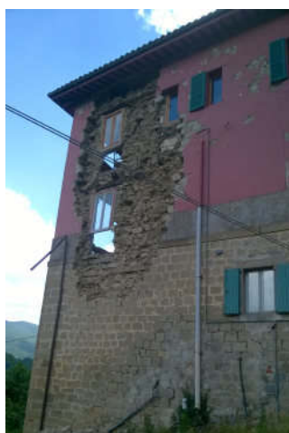
2. I telai delle finestre sono integri ed anche i loro vetri; attorno la muratura si è disarticolata e crollata. Risultano completamente ribaltate le scale di fragilità che abbiamo in mente (Montegallo, AP). 3. Aspetto delle macerie viste dall'alto (Pescara del Tronto, AP).
