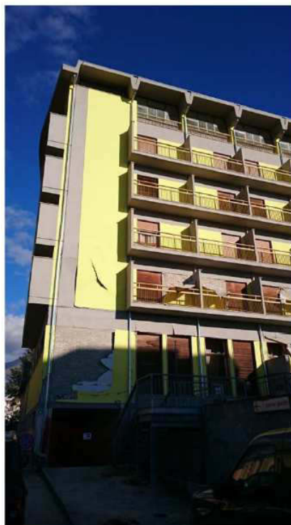
Amatrice: stesso Edificio in c.a., altro lato: si evidenziano minori danni
