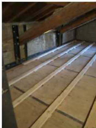
Villa Alessandrini solaio acetiaia
