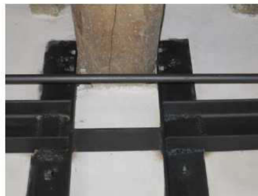
Villa Alessandrini telai e collegamento trave acetaia
