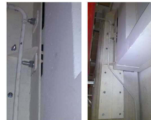
Una prova di carico Carpenterie travi - pilastri
