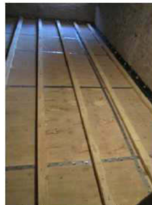
Villa Alessandrini rinforzo solai
