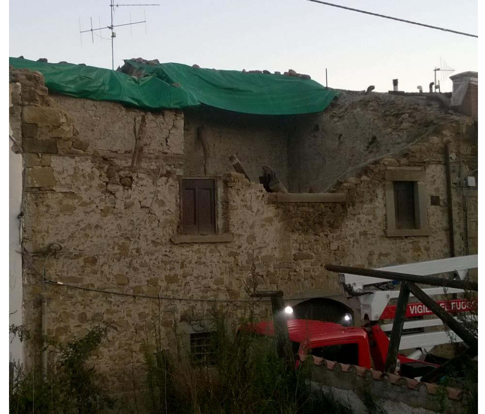
Crolli per disgregazione muraria (bassi IQM) (Amatrice)
