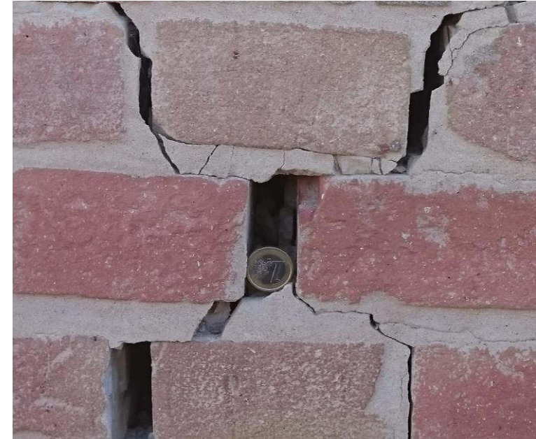
Danneggiamenti e apertura di fessure
