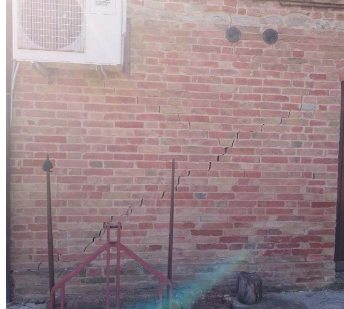
Danneggiamenti e apertura di fessure
